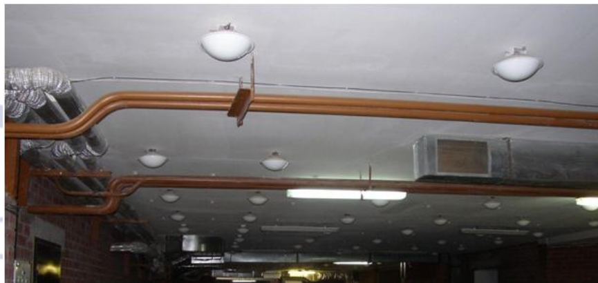
Рис. 22. Элементы установки порошкового пожаротушения модульного типа.
